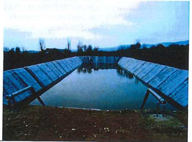
Réserve incendie 1500 m 3
