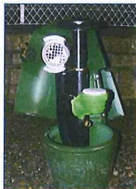
Intérieur d'une borne de puisage avec ½ raccord de 65 mm et compteur d'eau
